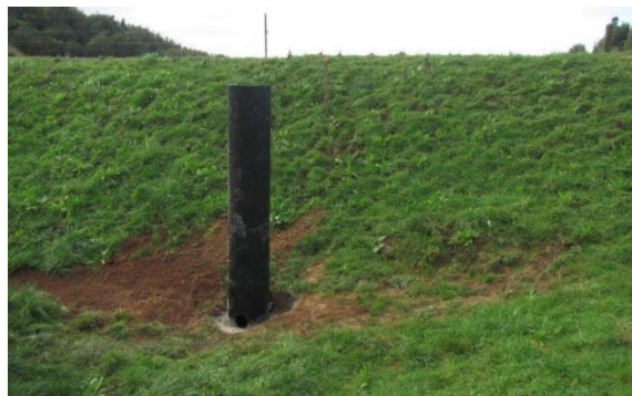
(d) Upstand Riser on the front of a DB embankment.
